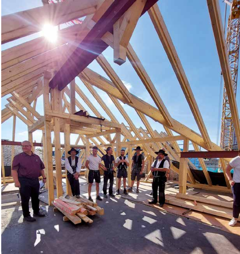
Inzwischen ist der neue Dachstuhl fertig. Am 25. September 2023 konnte Richtfest im Marienheim gefeiert werden.
